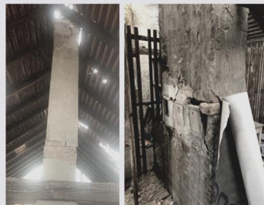
Slika 7. Oštećenja dimnjaka u razini tavnorskoga prostora
